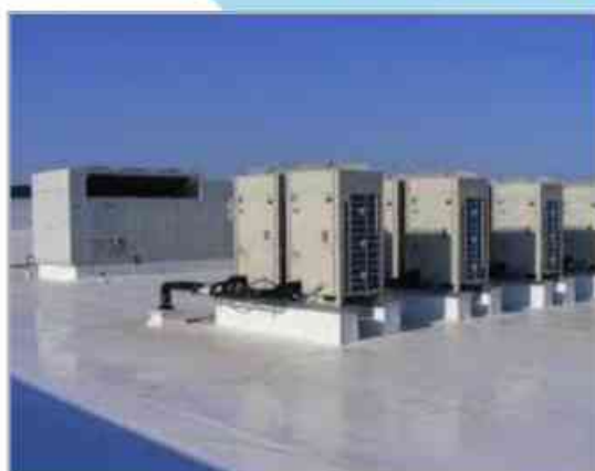
شکل ۱۲: پنل های خارجی سیستم VRF
